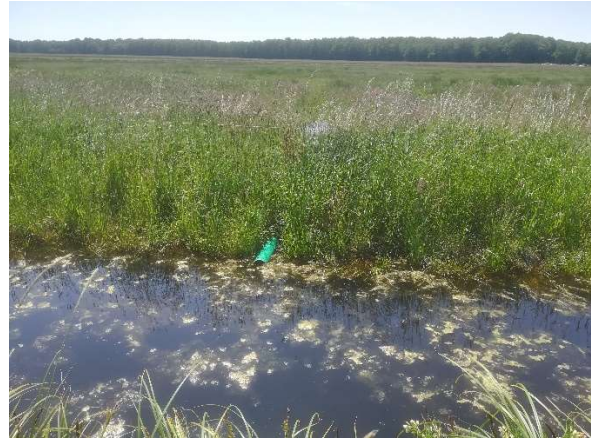
Abbildung 19 Hoch angestauter Graben durch Überstautest und Einlauf Wasser in Knickrohr, Polder Mönkebude Juni 2023
