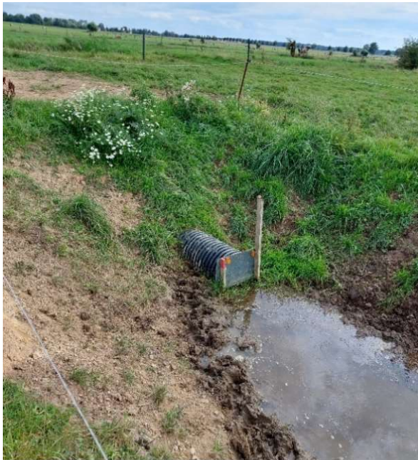
Abbildung 21 Polder Rosenhagen, Geschlossener Durchlass für Probestau, 25.08.2023
